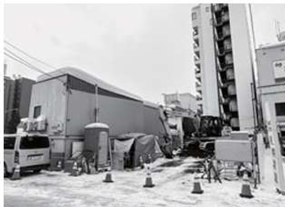
2月に着工した中央区南4条東1丁目のホテル建設地
